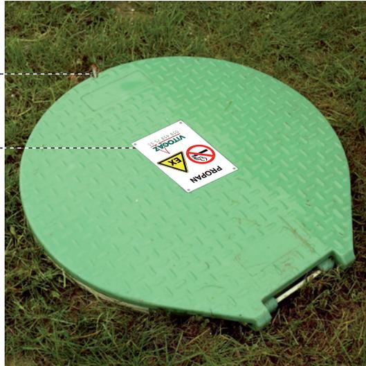
Tutte le rubinetterie del serbatoio sono protette da una copertura che si può chiudere a chiave. Chiudendo sistematicamente questa copertura, si impedisce a qualsiasi persona non autorizzata di manipolare le rubinetterie.
