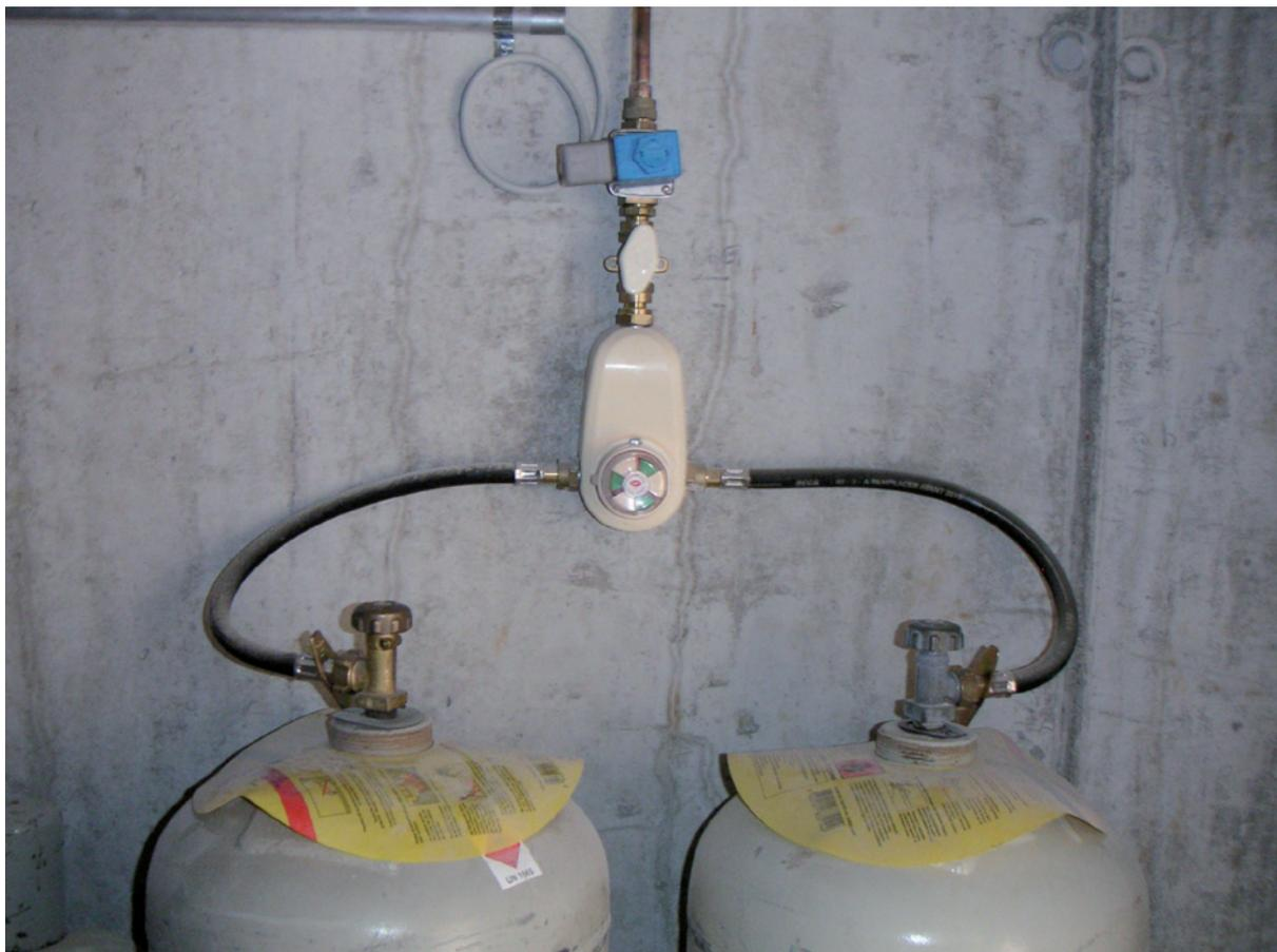
4. Schema di un impianto domestico a gas liquido con una batteria di bombole
